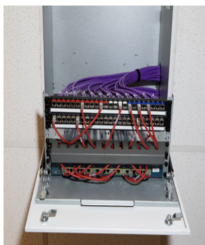
Установка активного оборудования
