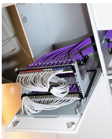
Установка пассивного оборудования
